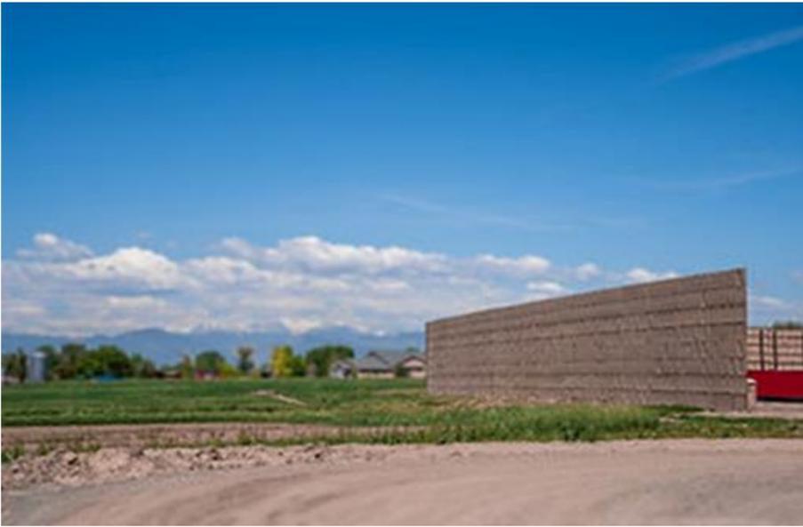
Utilizamos plataformas de perforación mejoradas con características de reducción de ruido y tecnología de fracturación hidráulica silenciosa. También utilizaremos un equipo de perforación eléctrico, el cual también reduce el ruido. Estas características reducen el ruido de nuestras operaciones. Además de mitigar el ruido en la fuente, también instalaremos paredes antisonoras.
