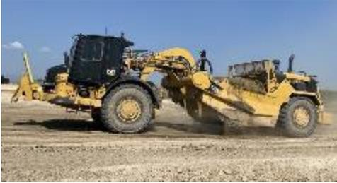
El equipo de construcción estándar prepara el sitio del pozo. Se puede instalar una pared para reducir o minimizar el ruido y la luz durante el desarrollo.
